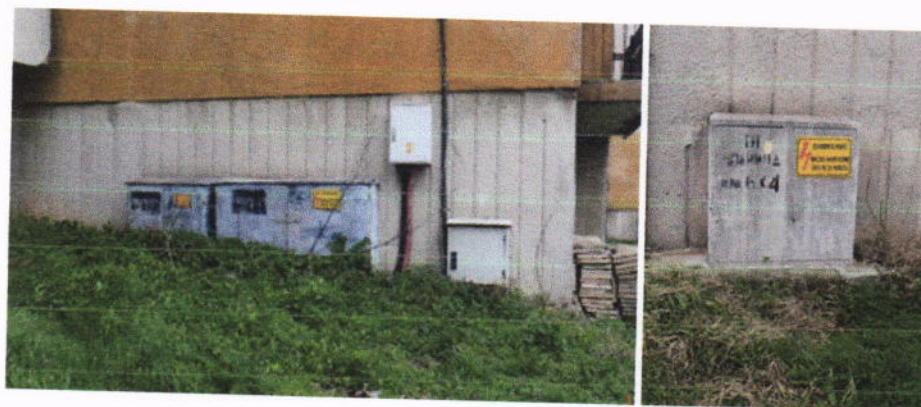
Фиг. 1.27. Кабелни касети тип ШКД за всяка секция
