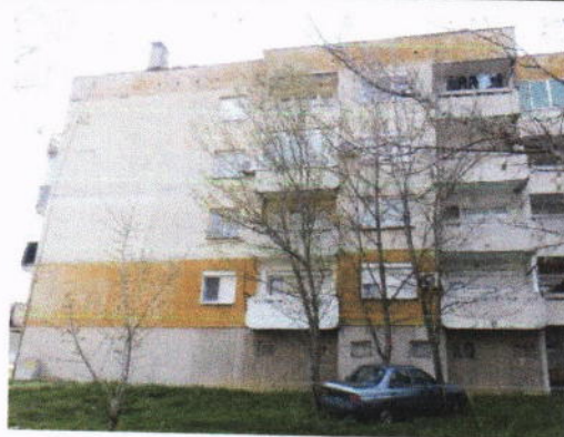
Фиг. 15. Източна фасада
