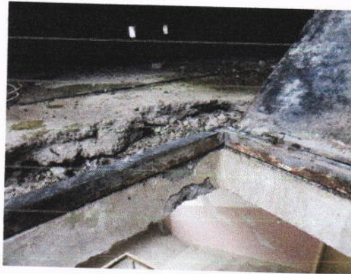
Фиг. 1.14. Подпокривно пространство
