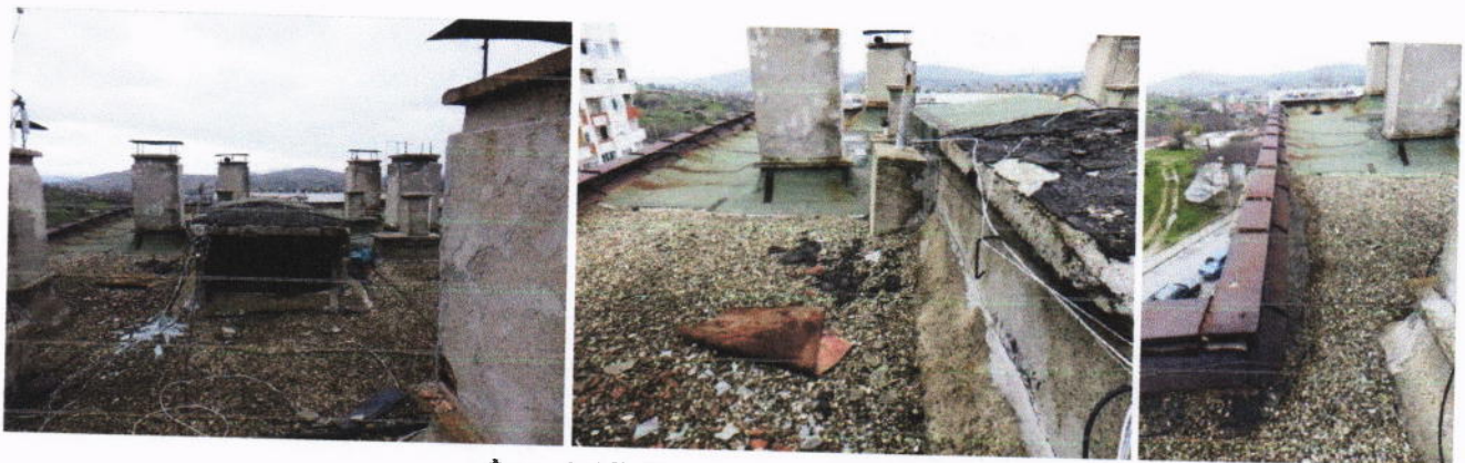
Фиг. 1.15. Покрив – общ изглед
